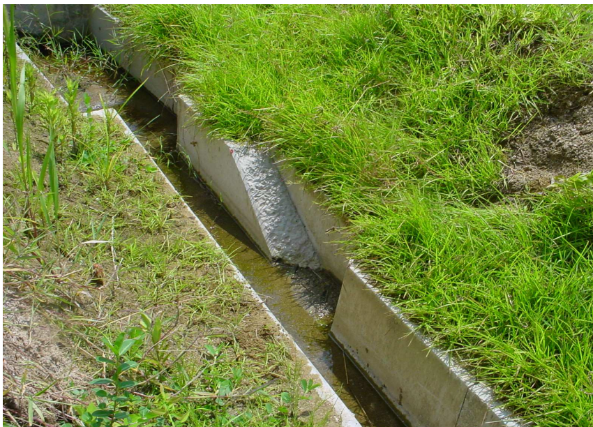
落ちた小動物・昆虫が這い出せるよう配慮されたU字溝の例 商品名「ハイダセール」
