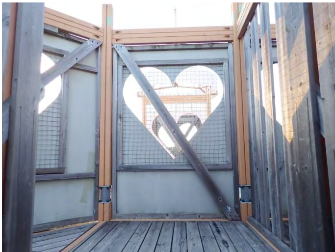
c. 筋交い状部材上端と外壁パネル枠材の接合
