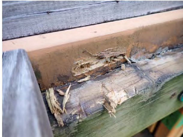
f. e の床受け木と梁側面の柔らかくなっていた部分
