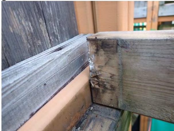
g. e の剥がした床板端面付近の腐朽菌菌糸
