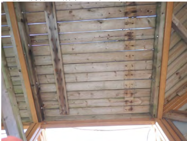
g. 床受け木、床板、棧の腐朽(409)
