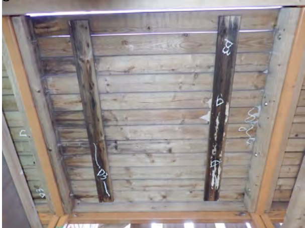
図5-5 4層の床裏面の腐朽の例
