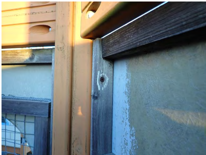
d. 筋交い状部材下端と梁の接合
