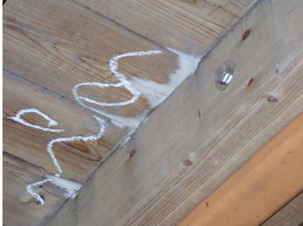
図5-5 4層の床裏面の腐朽の例
