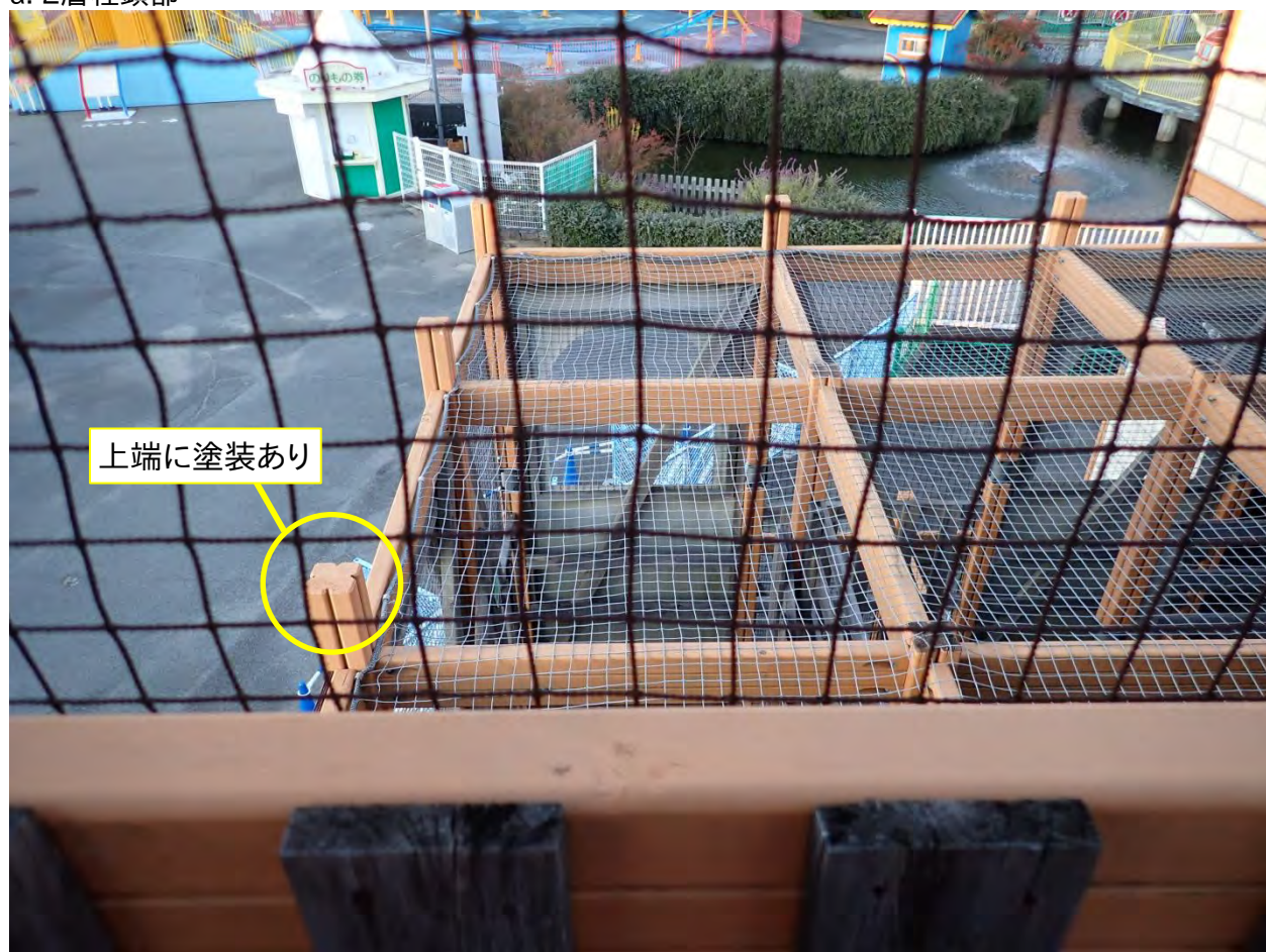
b. 柱上端が無塗装で腐朽が始まっているもの
