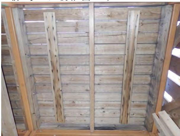
c. 床板の古い棧を外した部分(407)
