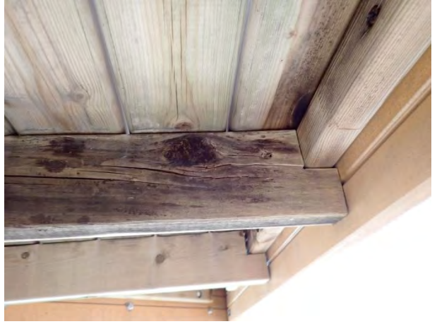
b. 腐朽の終盤状態の根太(032)
