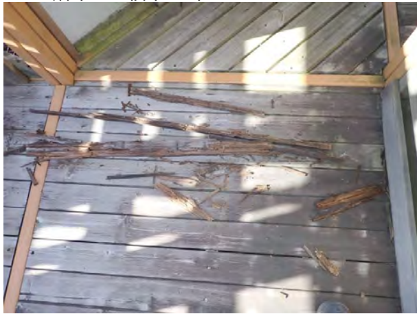
h. 床板受け木と床板腐朽部の拡大(409)
