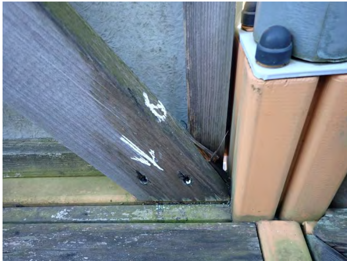
d. 筋交い状部材下端と梁の接合
