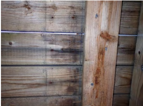
e. 棧が腐朽して落下した(404)
