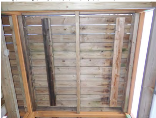
d. 床受け木の腐朽(407)
