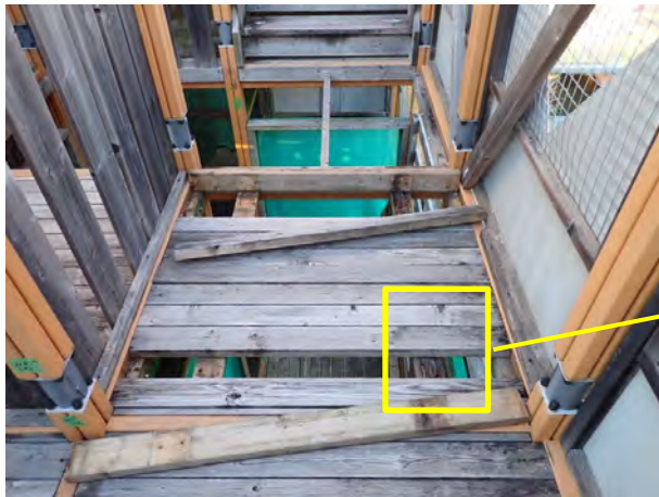
e. 床上面側で北西角付近の床板を剥がしたところ
