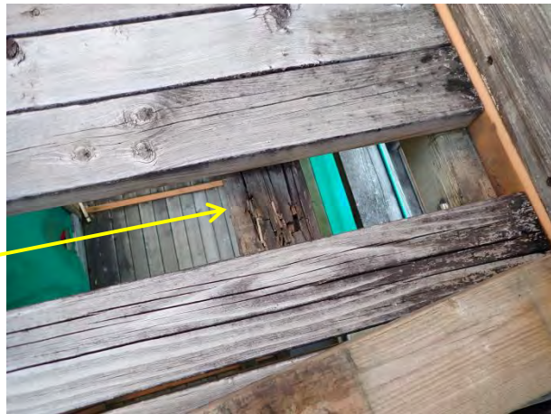
f. e の床受け木と梁側面の柔らかくなっていた部分
