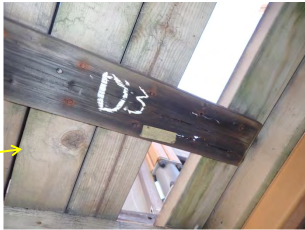
d. b を床上面側からみた棧の腐朽
