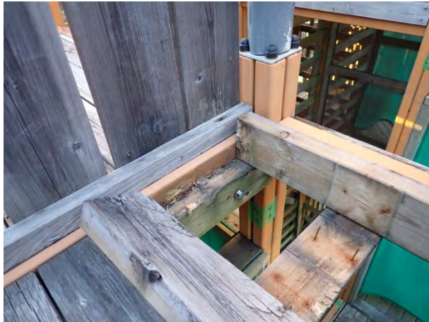
g. e の剥がした床板端面付近の腐朽菌菌糸
