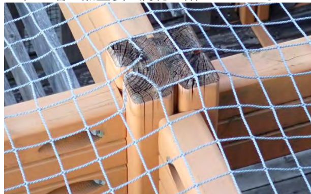
b. 柱上端が無塗装で腐朽が始まっているもの
