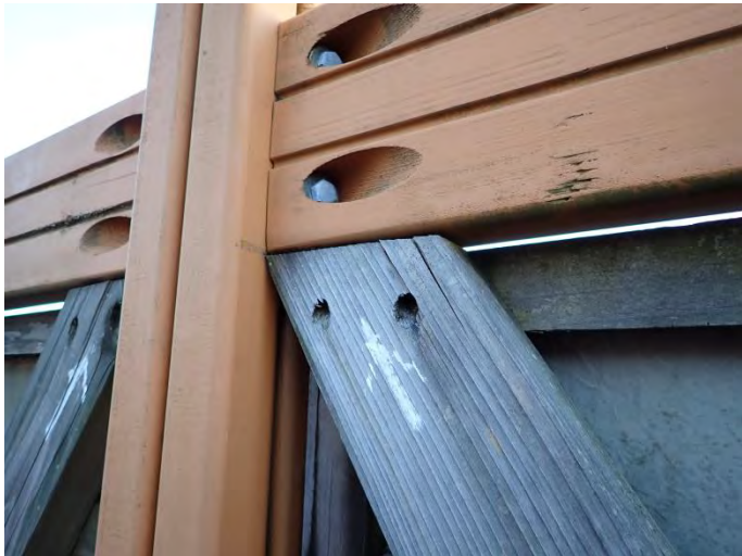
c. 筋交い状部材上端と外壁パネル枠材の接合
