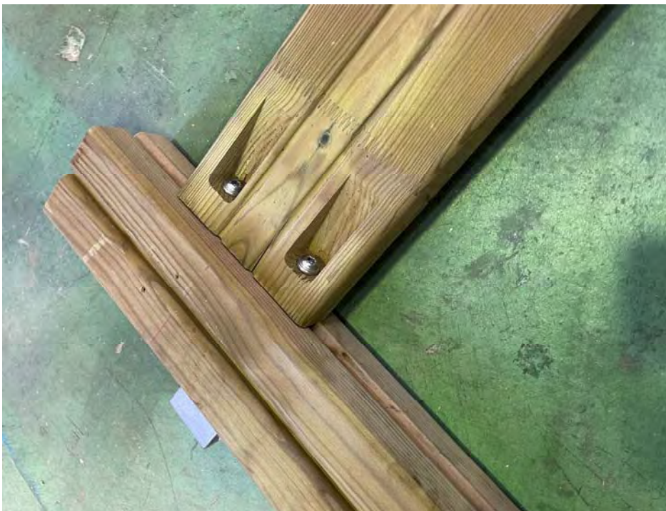
実験後の試験体（圧縮筋交い） 柱―梁接合金物状況 大きな損傷はない
