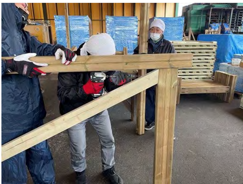
施工状況・ビス打ち込み長さは規など無く感覚で実施していた
