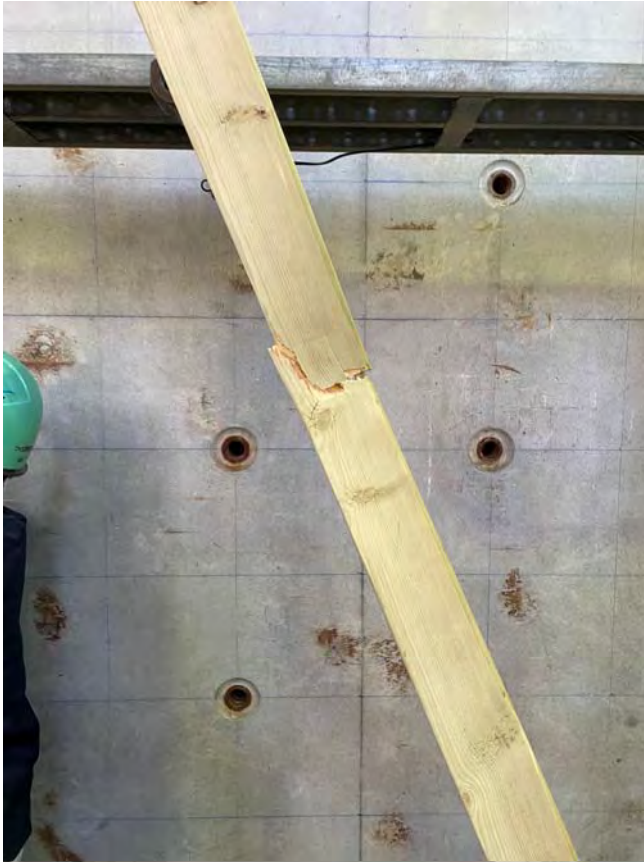
実験後の試験体（圧縮筋交い）筋交いの座屈状況
