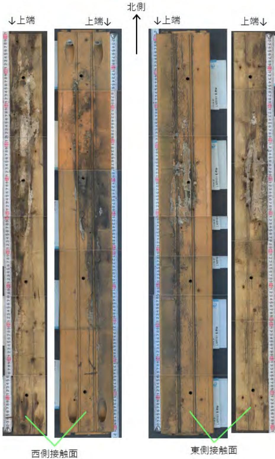
写真4 梁と床受け材の接触面の状況
