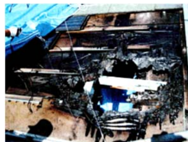
写真 A.11 屋根の被災状況 (右はモジュール撤去後)
