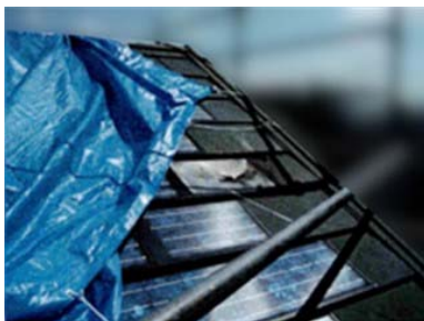
写真 A.11 屋根の被災状況 (右はモジュール撤去後)
