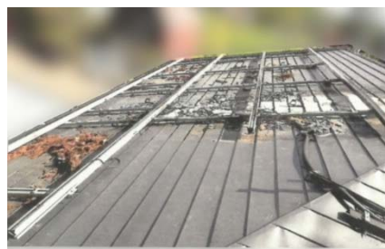
写真A.5 屋根の被災状況（右はモジュール撤去後）
