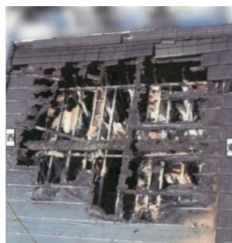
写真A.1 屋根の被災状況（右はモジュール撤去後）
