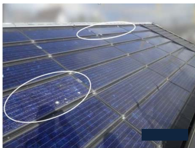
写真 12 モジュール表面のガラス割れ (左：アレイ外観で、丸囲い部がガラスの割れたモジュール 右：モジュール表面のガラス割れの部分拡大写真)
