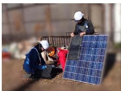
写真D. 3 セル回路の部分遮光 による測定
