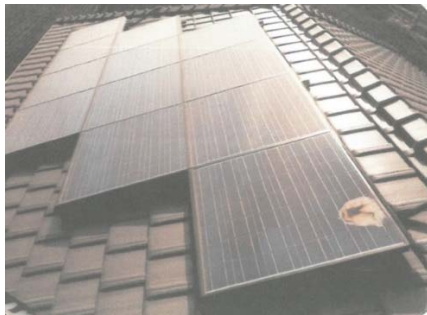
写真A.14 焼損したモジュール 写真A.15 焼損したアレイケーブル
