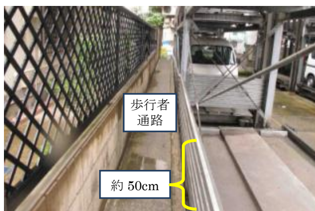
写真8 駐車場左側面と通用口への通路
