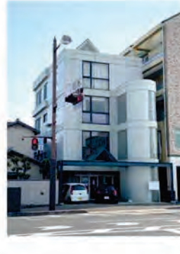
岡山支店／ショールーム
