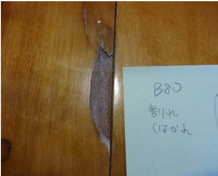
図 12 塗装・床材の剝離
